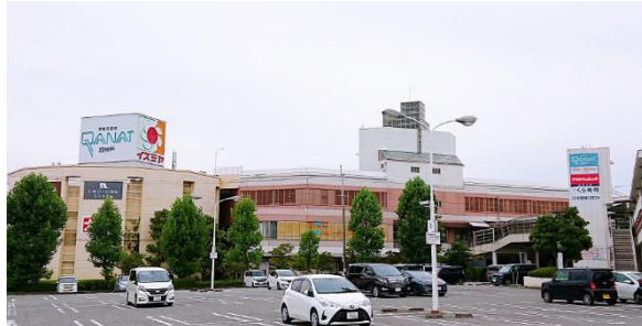
SC 西神戸外観写真
